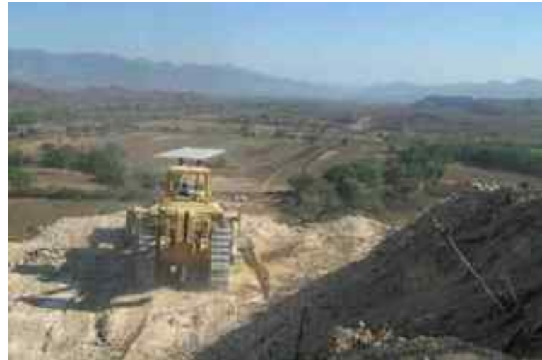
Excavación en corte km 60+280 AD
