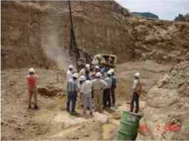
Puente Baluarte Excavación apoyo 5, Margen Durango.
