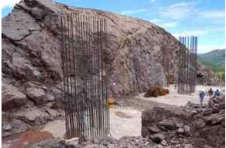
Puente Baluarte Zapata terminada apoyo 12, Margen Sinaloa.
