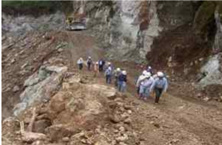
Puente Baluarte Camino de acceso para el apoyo 6, 7 y 8, Margen Sinaloa.
