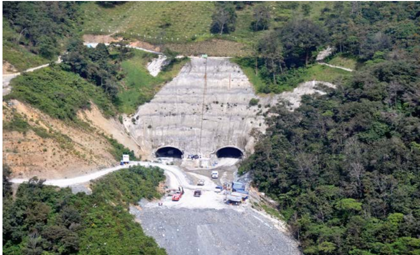
FIGURA 12.- Autopista Nuevo Necaxa - Tihuatlán
