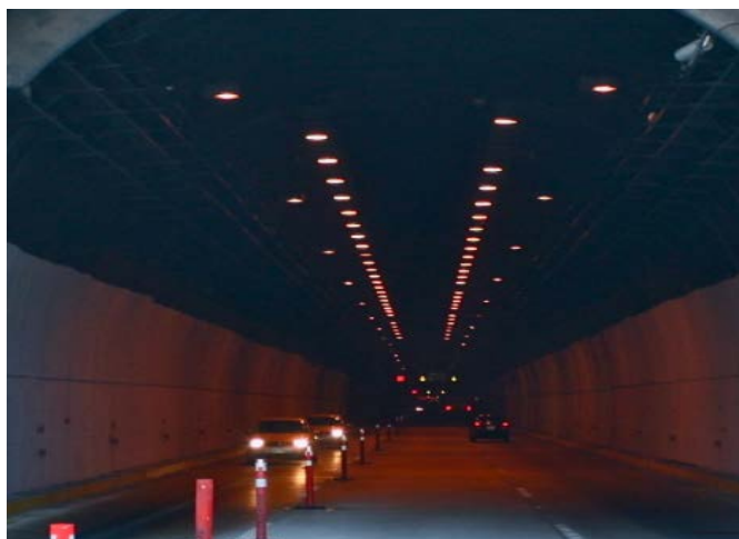
FIGURA 6.- Vista del interior túnel, zona de transición.
