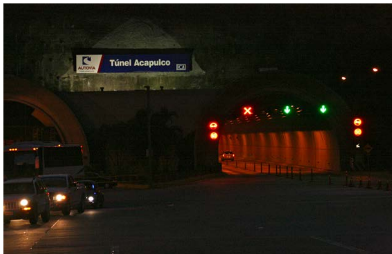
FIGURA 10.- Vista del inicio del túnel de noche e iluminación artificial.
