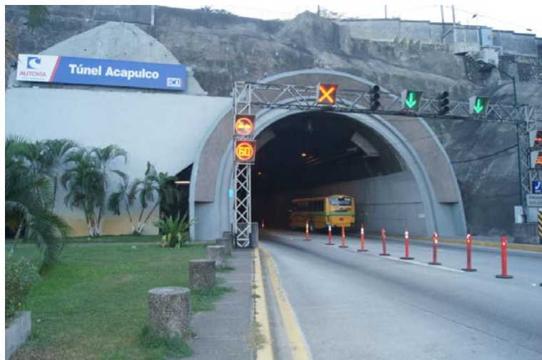
FIGURA 4.- Sistema de Control de Tráfico
