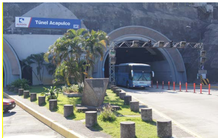
FIGURA 1.- Portal México Túnel Acapulco
