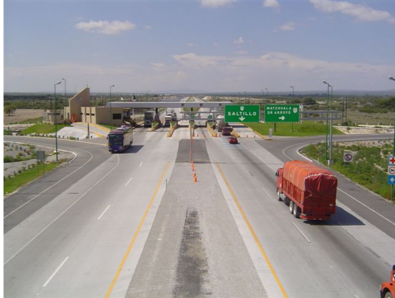
Caseta de Cobro
