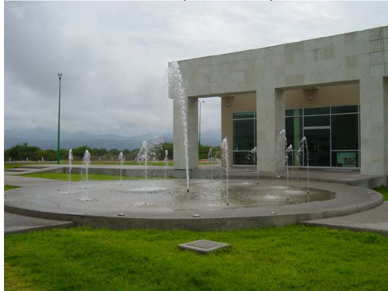
Parador (Vista diurna)
