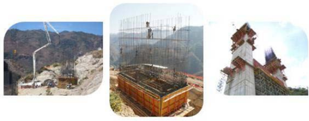
FIGURA 4.- Armado y colado de apoyos
