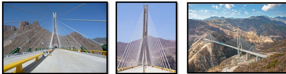
FIGURA 16. Inspección final del puente
