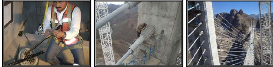
FIGURA 14. Instalación de torones
