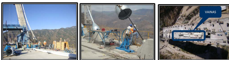
FIGURA 13. Instalación de vainas
