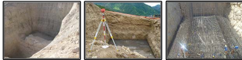
FIGURA 2.- Excavación de zapatas y armado de acero de refuerzo
