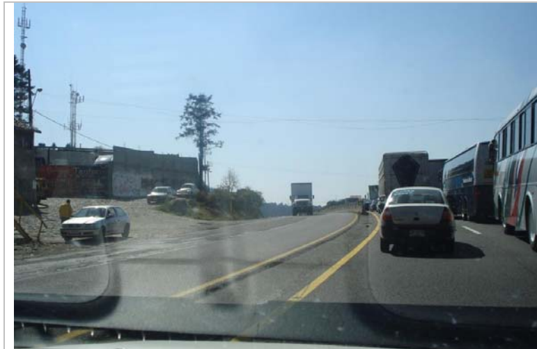
FIGURA 8. Discontinuidad en la barrera central y acceso directo de vehículos a comercios aledaños
